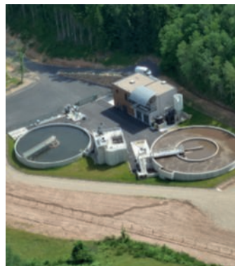
Station d'épuration d'Espalion
