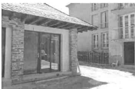
LOGEMENTS D'ESTAING Réhabilitation de l'ancienne gendarmerie d'Estaing
