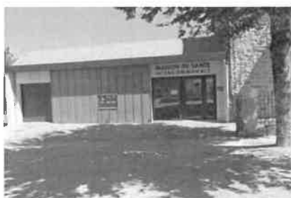
MAISON DE SANTE DE CAMPUAC Travaux en cours dès Mars 2018
