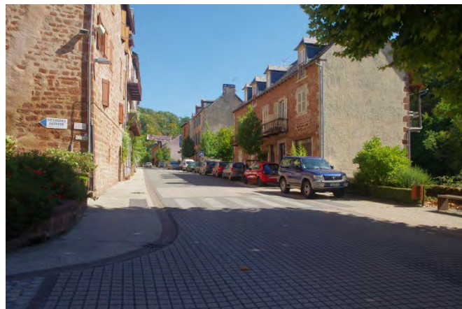
L'entrée très marquante sur Villecomtal par l'architecture patrimoniale
