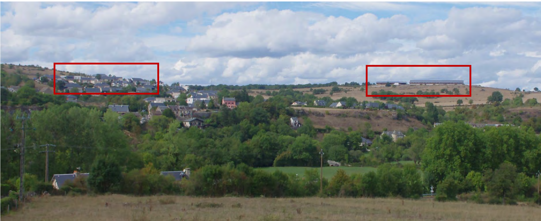
Vue depuis Bennac vers la colline de Gages où l'implantation d'un hangar agricole en ligne de crête se distingue
