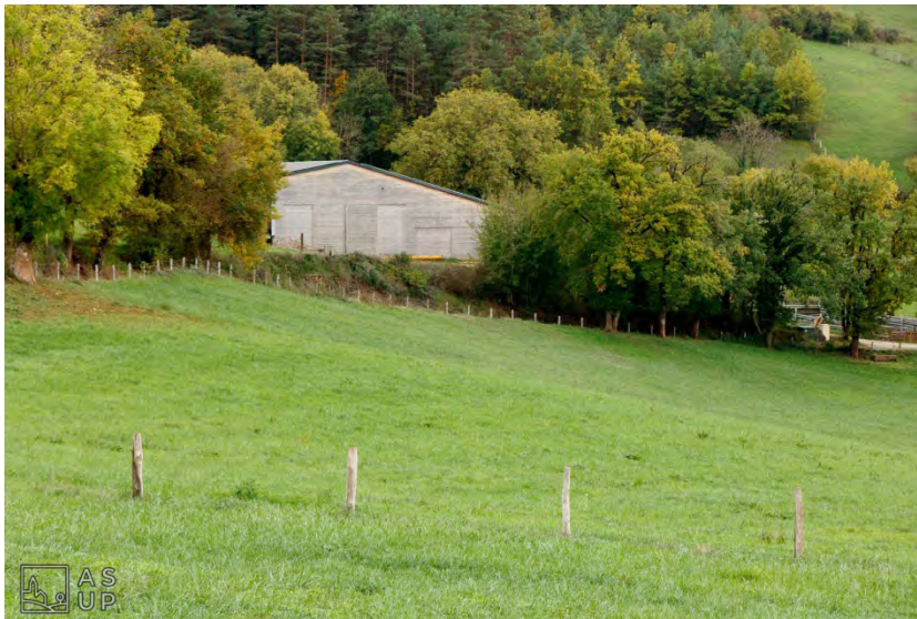
Faible incidence paysagère de deux bâtiments agricoles dans le paysage
