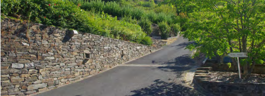
Un mur de soutènement en schiste dans le hameau de Pons (St-Hippolyte)
