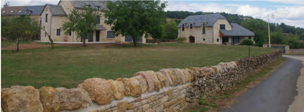
Un muret récent reprenant le même appareillage que le muret historique, dans le hameau de Grioudas (Montrozier)
