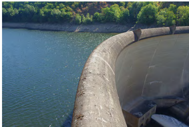
Le barrage de Couesques
